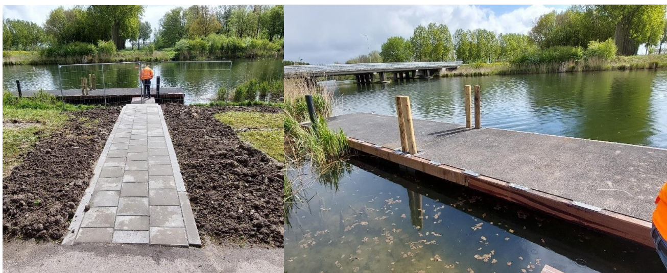
Figuur 2: Nieuwe situatie nabij restaurant De Beren
