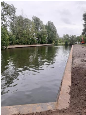
Nieuwe aanlegvoorziening Robbe Roggekreek
