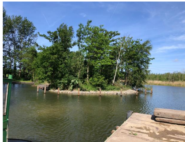
Steenbestorting aangebracht eiland Krimplaat
